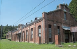
旧丸山変電所
